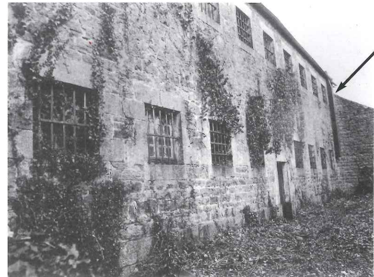
Cellulaire imparfait : ici la cour des condamnés. Ce qui convient : au fond, à droite, le mur de séparation des cours. Des cellules de l'étage, les hommes ne pourront regarder dans la cour des femmes (voir la hauteur du mur au départ). Ce qui ne convient pas : les fenêtres des cellules des hommes donnent sur cette cour ; les détenus peuvent donc communiquer entre eux...
