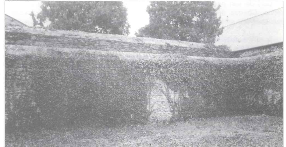
Une architecture dissuasive : les murs du chemin de ronde. Si quelque détenu réussit à escalader le mur intérieur, il lui restera à franchir le mur extérieur, encore plus haut que le premier, et bien visible de toutes les cours.
