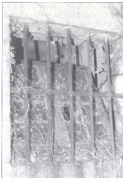
Réponse au cellulaire imparfait dans la cour des femmes : la fenêtre n'a pas été changée, mais elle s'ouvre sur une charnière horizontale.
