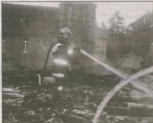
● Sur le toit de la prison, l'effondrement de la charpente a rendu extrêmement difficile l'intervention des sapeurs-pompiers.
